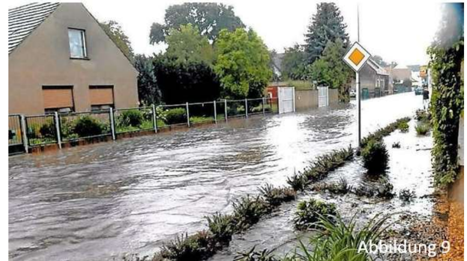
In der Vergangenheit mehrmaliger Überstau der Ströbitzer Hauptstraße aufgrund stark gedrosselter Ableitung in den Ströbitzer Landgraben
